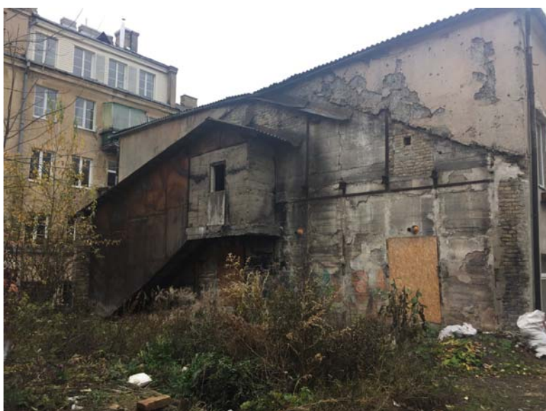
Vaizdas į esamą pastatą (bendra esamo ir rekonstruojamo pastato siena)
