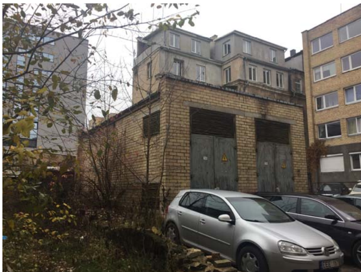
Šalia stovinti transformatorinė
